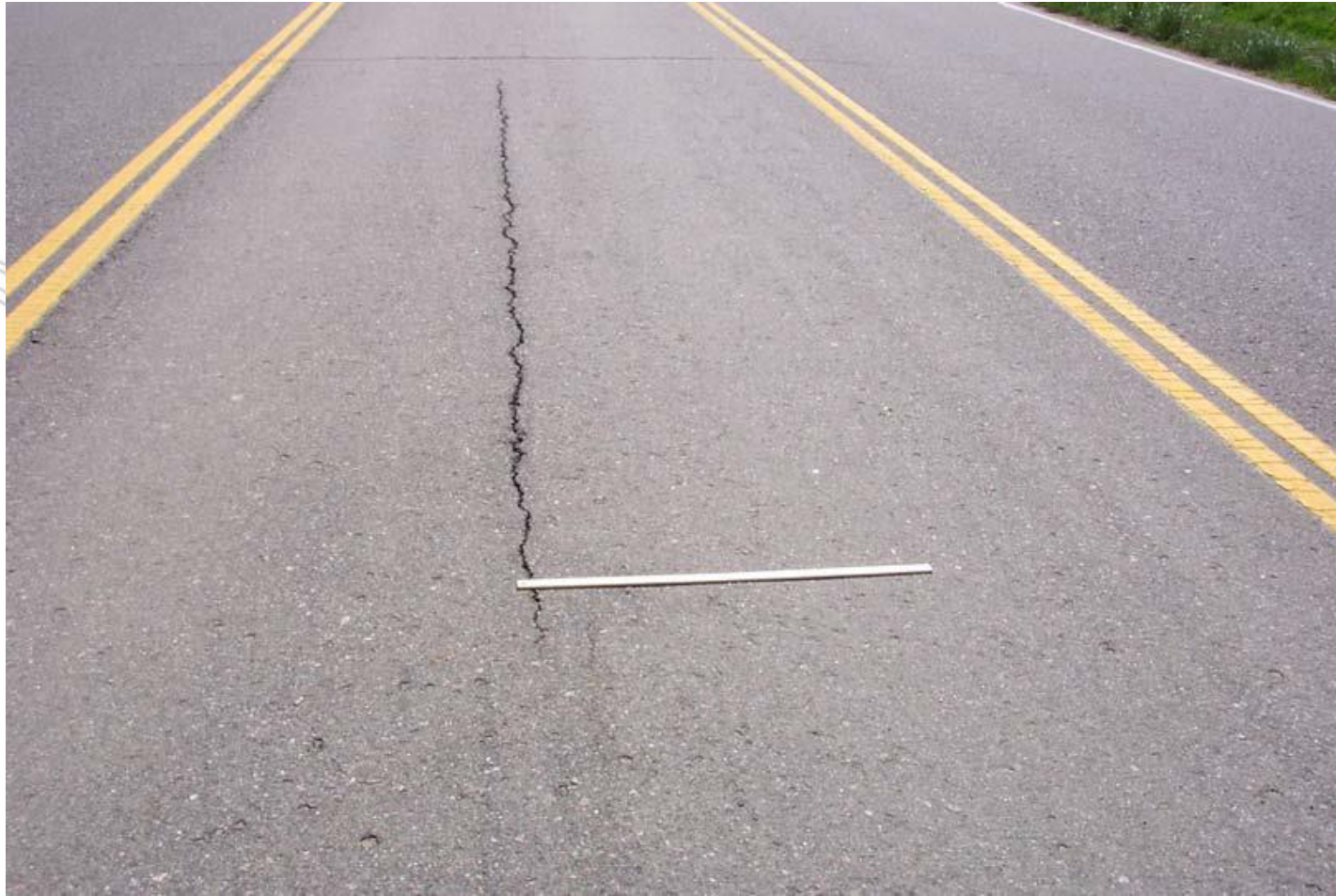
Longitudinal Cracking
